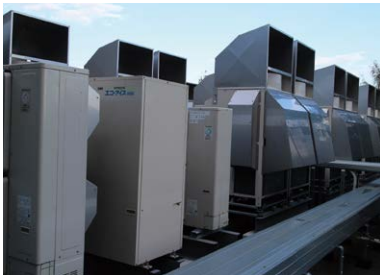
空水冷熱源ヒートポンプ(室外ユニット)
