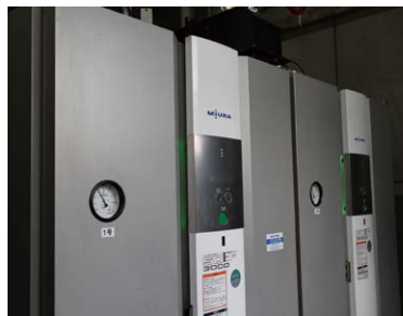
蒸気ボイラー
