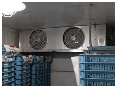
冷凍機(冷凍庫内部)
