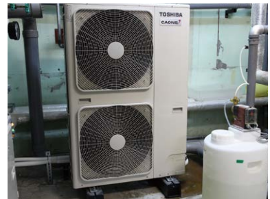
空気熱源ヒートポンプ
