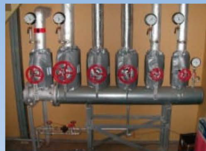
ボイラー周辺の無断熱弁類の断熱化
