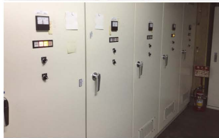
▲ポンプ(上)とインバータ制御装置(下)
