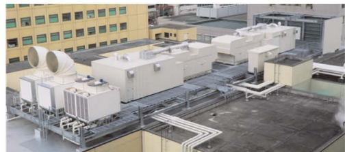
▲常用発電機（CGS）外観
