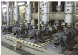
▲病院内のポンプとモーター（手前）
