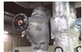
▲保温カバーによる蒸気配管の断熱強化
