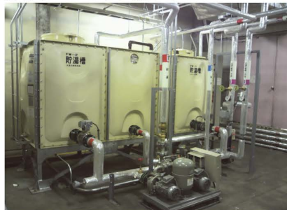
▲太陽熱+空気熱 貯湯槽
