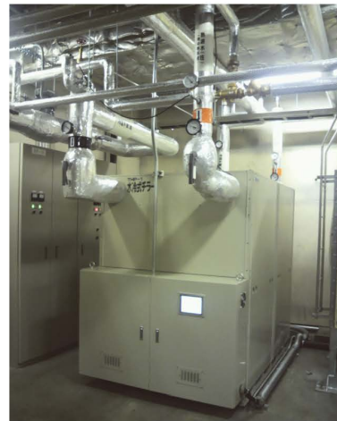
▲地中熱ヒートポンプ チラー
