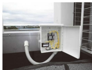
▲エアコンの自動制御盤
