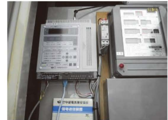
▲デマンド監視装置
