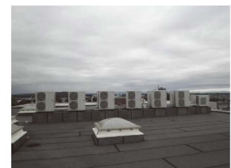
▲ヒートポンプエアコン 14台 (合計消費電力76kWを自動制御)
