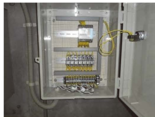
▲自動空調装置
