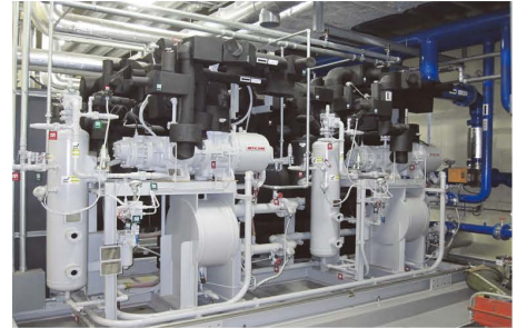
▲高効率冷蔵冷凍設備
