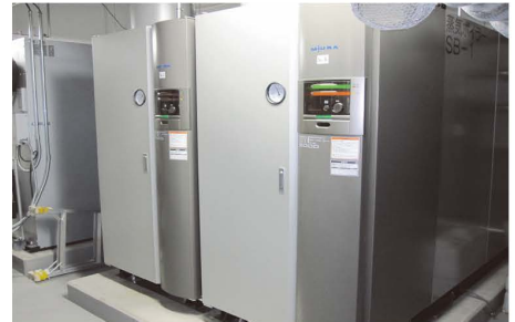
▲排熱回収高効率ボイラー
