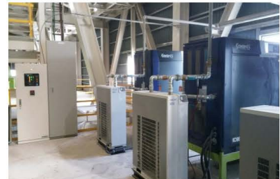
▲コンプレッサー
