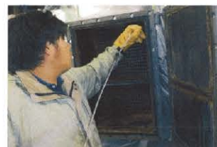
▲冷温水発生機熱交換器チューブの薬品洗浄
