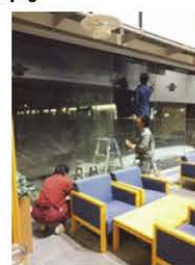
▲ロビー南東ガラス面のコート剤塗布
