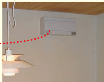
壁掛型熱交換換気扇の設置例
