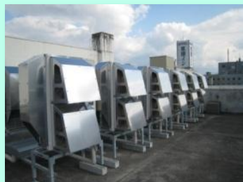
▲ヒートポンプエアコン室外機
