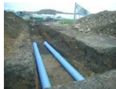
▲熱交換パイプ
