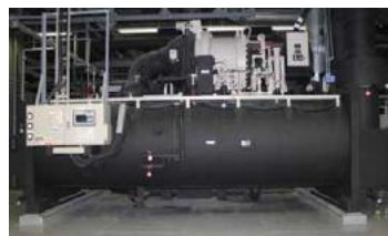
省エネ設備の導入(高効率ターボ冷凍機)
