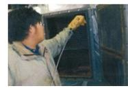
▲冷温水発生機熱交換器チューブの薬品洗浄
