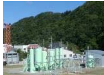
<ガス発生設備（豊富町）>
