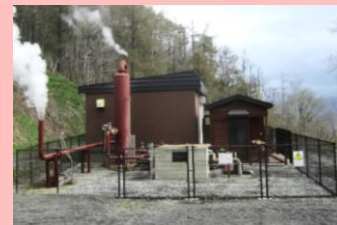
洞爺湖温泉利用協同組合 地熱発電設備
