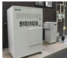
[左手前]固体酸化物形燃料電池(SOFC) [右奥]AI搭載のロードヒーティングシステム
