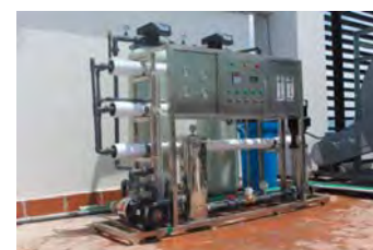
ホテル向け水処理設備
