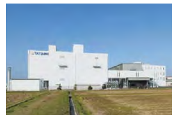
2015年12月新設のP号棟
