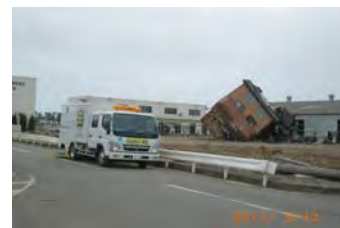
東日本大震災被災地での調査状況
