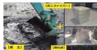
ボンテラン工法
