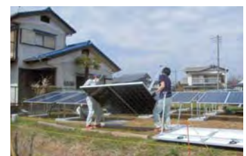
狭小地に施工中の小型軽量 FRD 架台 (パネル 2 枚が 1 セット)
