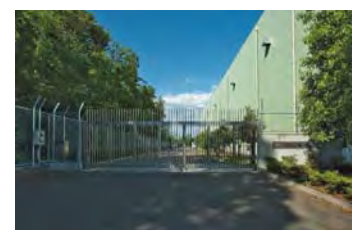
保管施設外観
