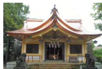
神社の屋根補修完了
