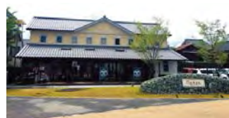
「まちの駅 Nanze」 古い町並みにとけ込んでいる
