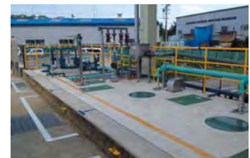
同上プラントの外観
