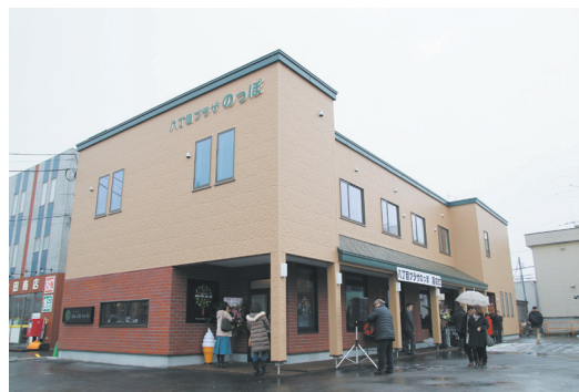
「八丁目プラザのっぽ」外観
