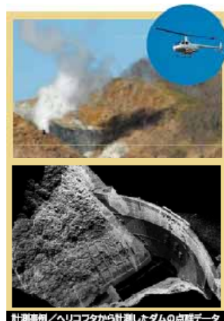
計測事例/ヘリコプタから計測したダム の点群データ
