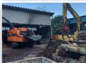
作業管理・安全性向上
