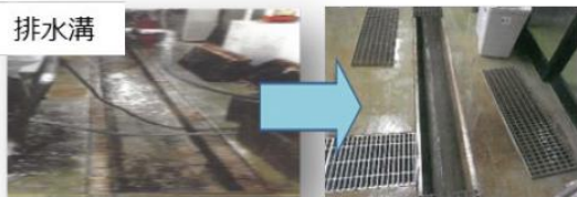
施設の衛生管理の強化に向けた排水溝、床、壁等の改修
