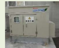
災害用LPガスバルク貯槽と非常用LPガス発電機
