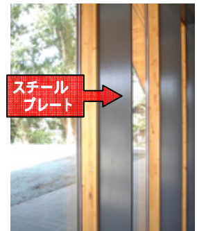
カーテンウォールの取り付け構造(特許)
