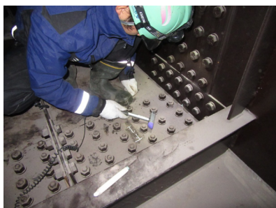
測定状況(ボルトテスター)
