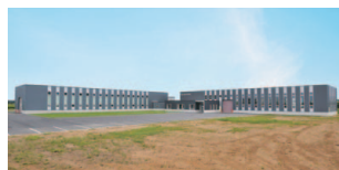
平成23年に生産拠点を石狩市に集約しました。
