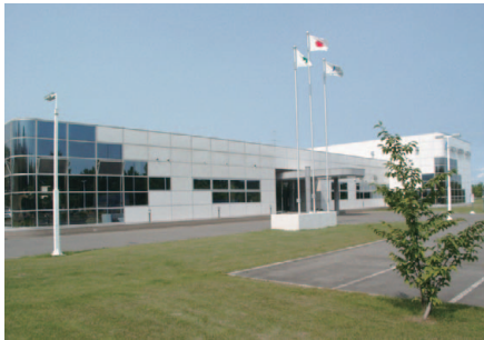
(株)安西製作所 北海道支店 全景
