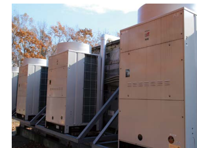
インバーター制御付冷凍機
