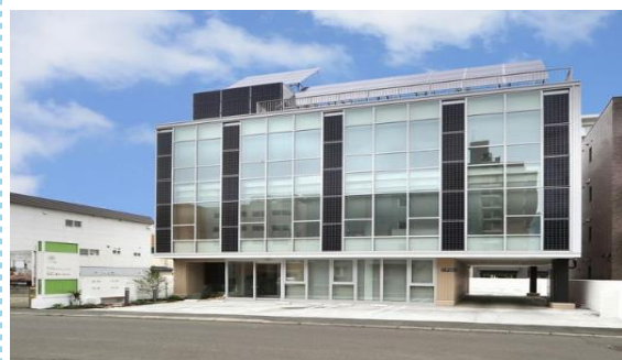
【平成30年度大賞】 株式会社アリガプランニング テーマ『道内初のランク「ZEB」(106%) を実現したアリガプランニング新社屋』
