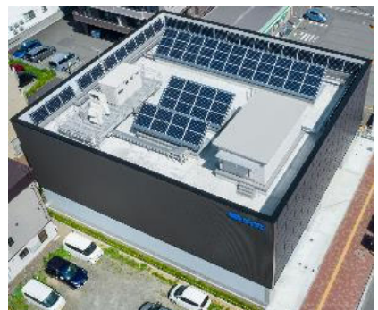
積雪に配慮し、屋上と壁面に太陽光発電設備を設置
