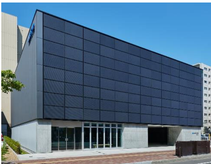
積雪に配慮し、屋上と壁面に太陽光発電設備を設置
