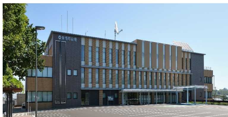
▲庁舎外観（高性能断熱材、Low-E 複層ガラスの採用）
