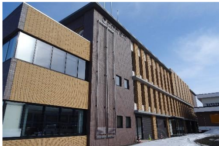
【美幌町 ZEB Ready庁舎】
