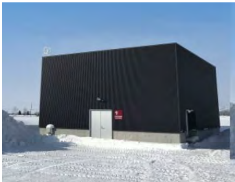
【データセンター実証試験施設】
