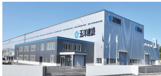
【令和5年度大賞 五洋建設(株)室蘭製作所】
