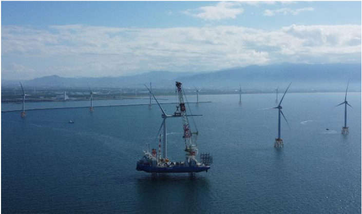
▲石狩湾新港洋上風力発電所とSEP船
