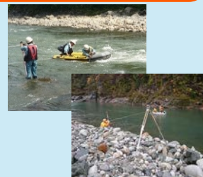
流量調査・測量作業
