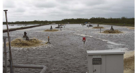
▲曝気処理装置（エアレーター）の運転を半減
