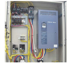
▲ポンプのインバーター制御装置
