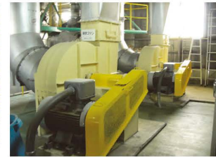
▲省エネベルトを使用する排気ファン
