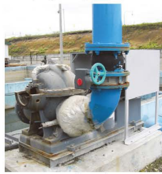
▲床排水ポンプ
