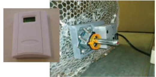
▲CO2センサーと連動する換気設備
