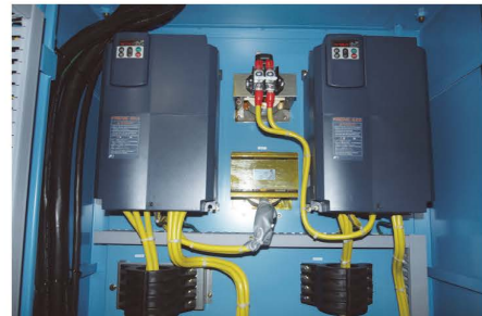
▲空調機のインバーター装置
