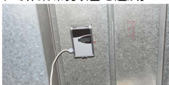
←還気ダクトに設置したCO2センサー
