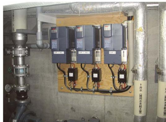
▲動力ポンプをインバータにて出力を制御する装置×6台分。
