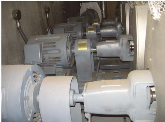
▲動力ポンプをインバータにて出力を制御する。
