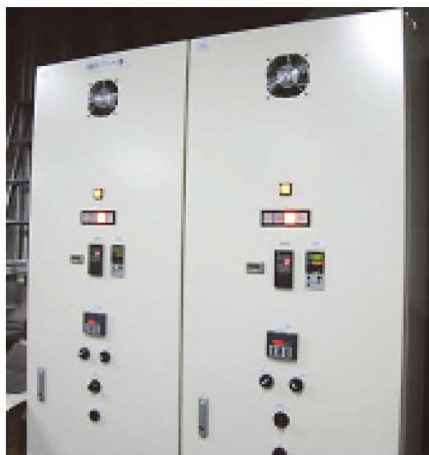
▲冷水ポンプインバータ制御装置
