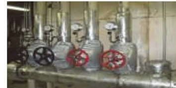
▲蒸気バルブの保温状況
