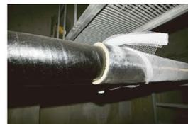
▲二重保温による蒸気配管の保温強化
