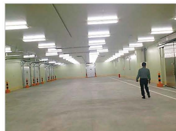
▲倉庫内LED照明
