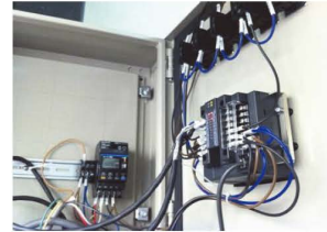
▲ピークカットを行う暖房制御盤
