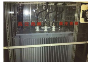
▲トッランナー変圧器
