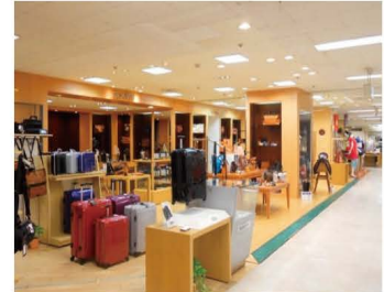
▲直管形のHf型蛍光灯(右)とLED電球(左)を組み合わせた天井照明
