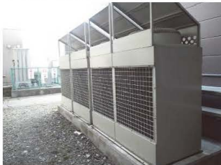
▲ヒートポンプエアコン室外機 (6台をグループ自動制御)
