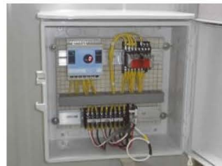
▲エアコンの自動制御盤
