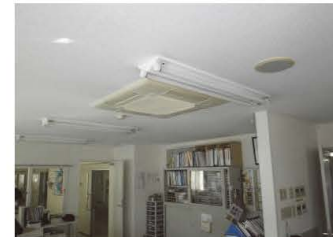
▲空調制御を行なっている ナースステーション室の様子
