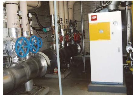
▲高効率小型貫流ボイラーと融雪状況遠隔監視による自動蒸気通気システム
