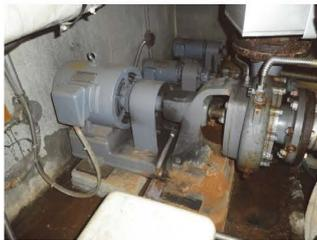
▲インバータ制御とした冷温水ポンプ
