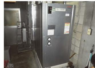
▲警報発生時に自動停止する冷凍機
