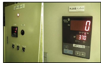
▲高効率空調機インバーター
