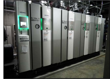
▲天然ガスボイラー
