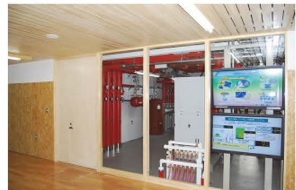
▲ガラス張りの機械室
